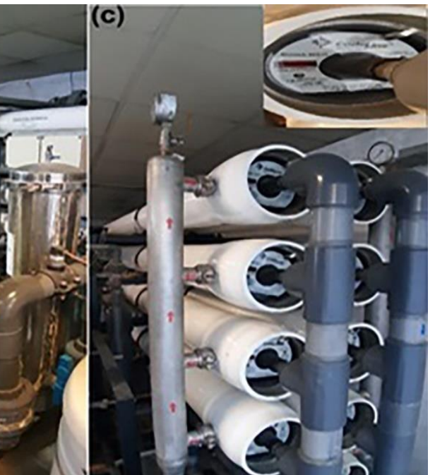
شکل ۵. تصاویر (a) صافی شنی، (b) کارتریجی و (c) غشایی اسمز معکوس در تصفیه‌خانه جدید نیروگاه طرشت.
