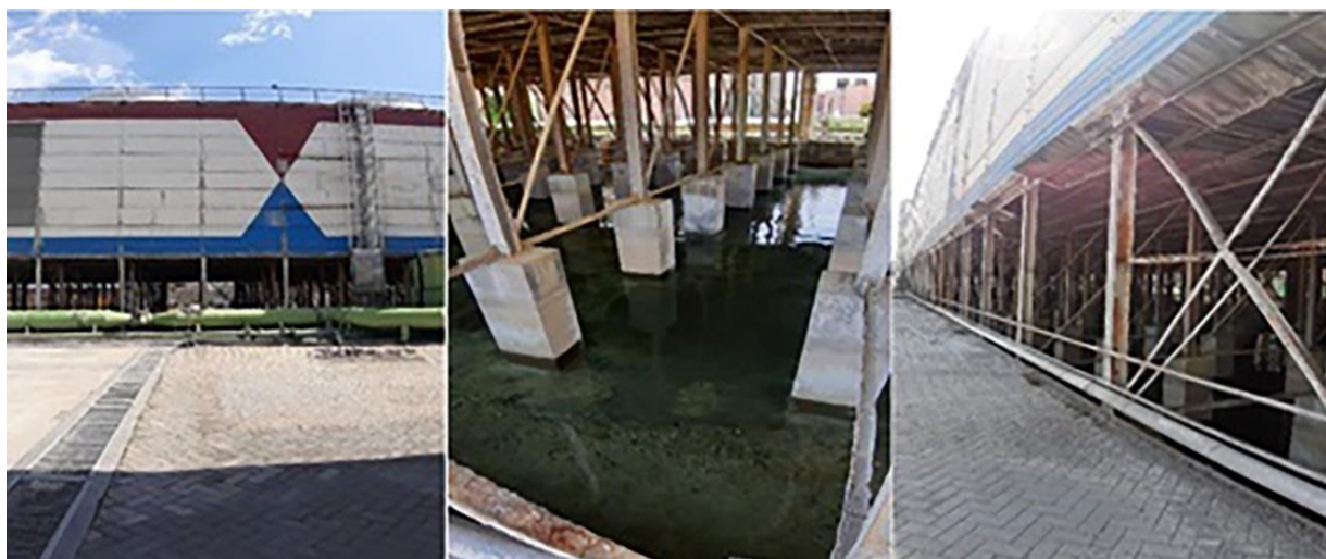
شکل ۶. تصاویر برج خنک‌کننده تر نیروگاه طرشت.
