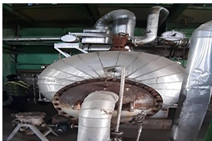
شکل ۴. تصویر تبخیرکننده آب مقطر ساز.
