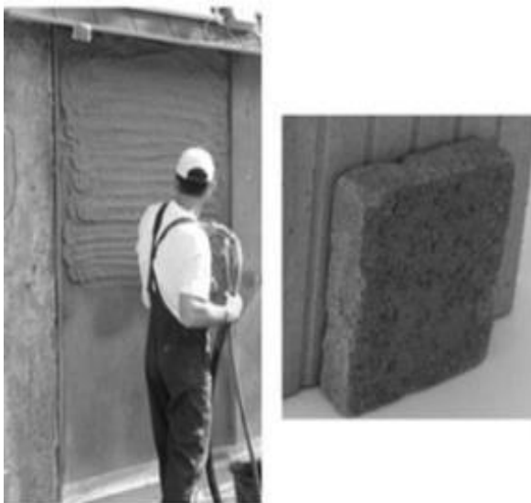
شکل ۶. پوشش عایق ارائه شده ایروژل پایه.
