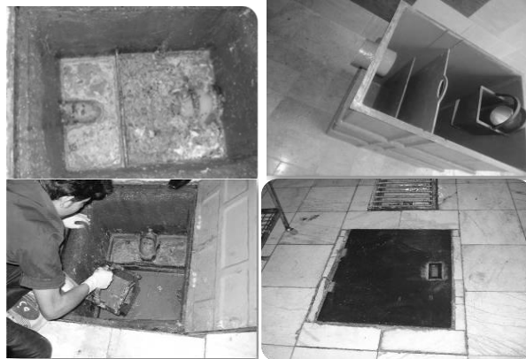
شکل ۳. نمونه سامانه چربی‌گیر اجراشده در یک رستوران توسط تیم تحقیقاتی.
