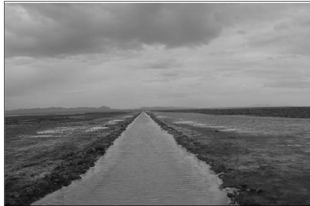
شکل ۲- کانال جمع آوری شورابه در پوسته نمکی پلایای خور [۶]
